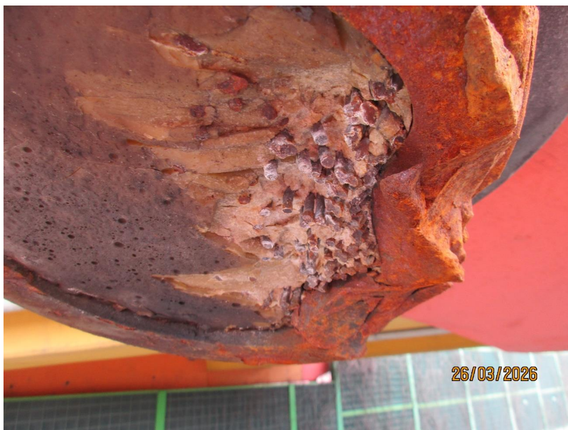
Zdj. 3. Uszkodzenie zakotwienia wanty nr 4 na poprzecznicy nr 2 w przekroju D-D.
