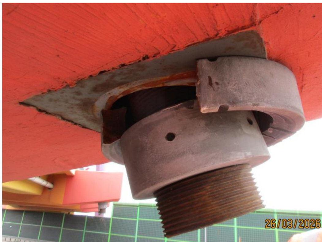
Zdj. 2. Widok uszkodzenia zakotwienia wanty, w miejscu kolizji nad pasem wolnym drogi S14 str. P.
