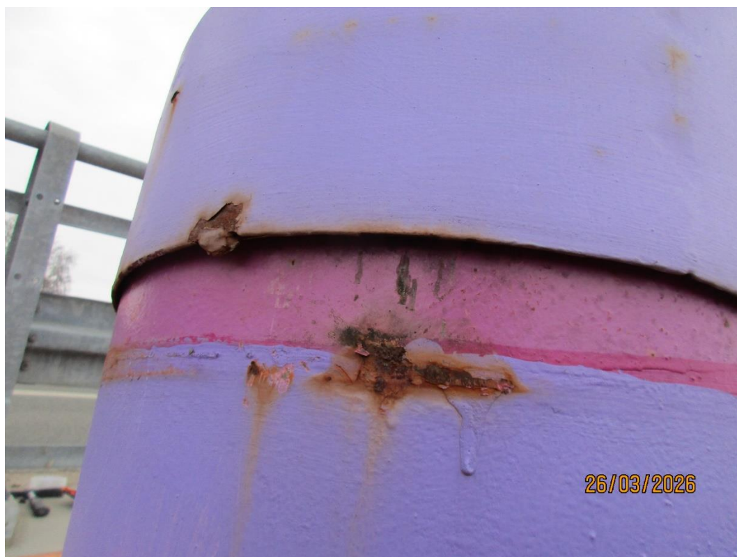
Zdj. 6 Przesunięcie przykrycia rury osłonowej wanty nr 4.
