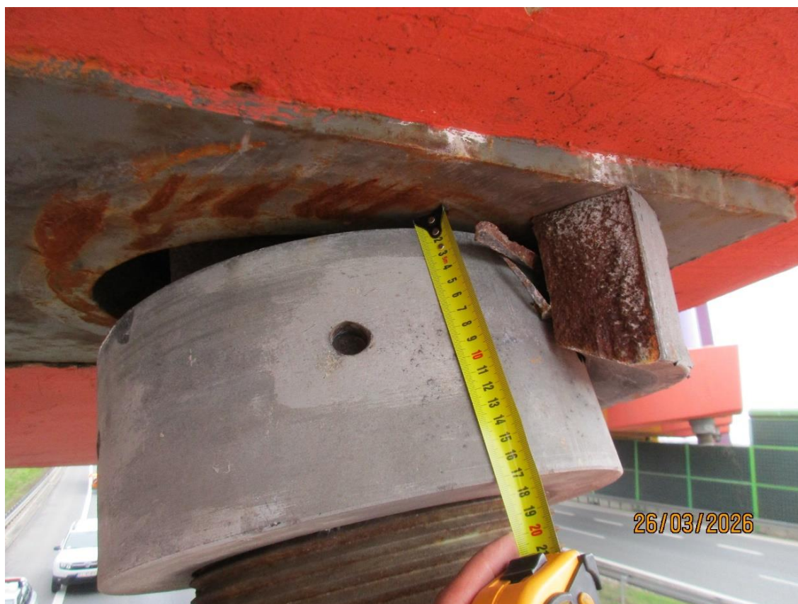
Zdj. 3. Uszkodzenie zakotwienia wanty nr 4 na poprzecznicy nr 2 w przekroju D-D.
