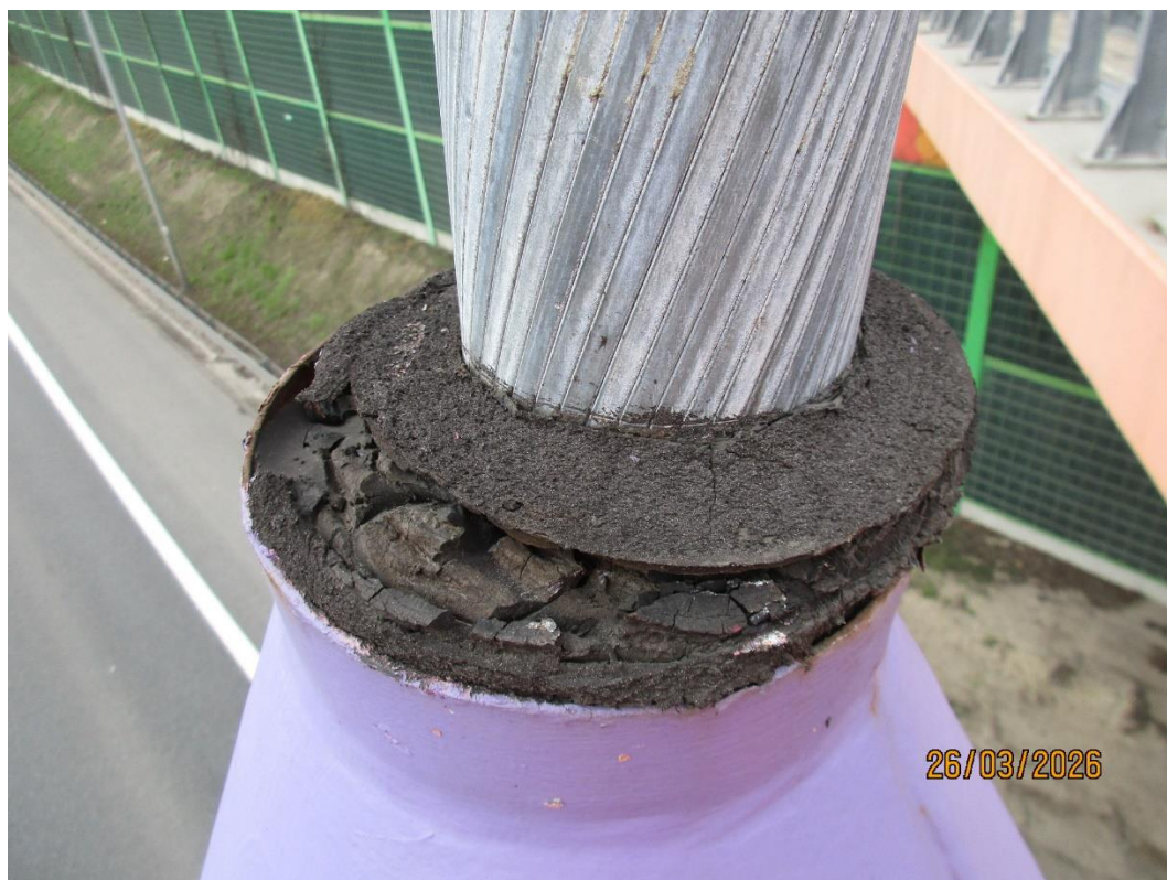
Zdj. 5. Uszkodzenie uszczelnienie i przesunięcie wanty nr 4.
